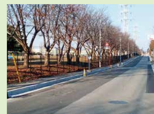
三角町千種町雨水浸透ます整備
