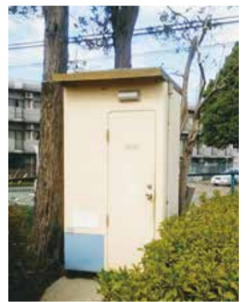
改修が急がれる簡易型トイレ
