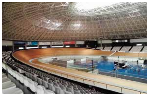
ドーム型の自転車競技場「伊豆ベロドローム」
